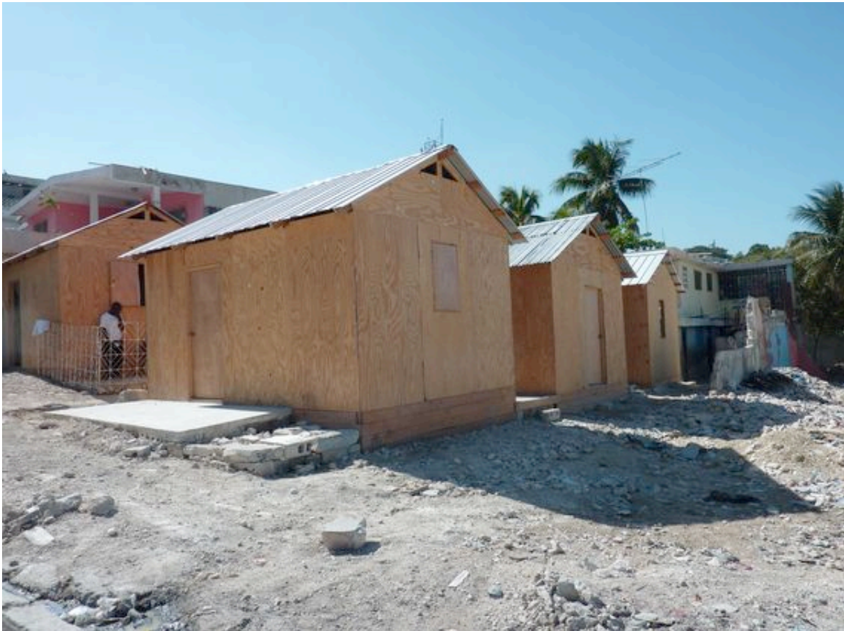
Installation d'abris provisoires On ne reconstruit pas une ville en posant des petites maisons précaires côte à côte Port au Prince, (Boyer, 2011)
