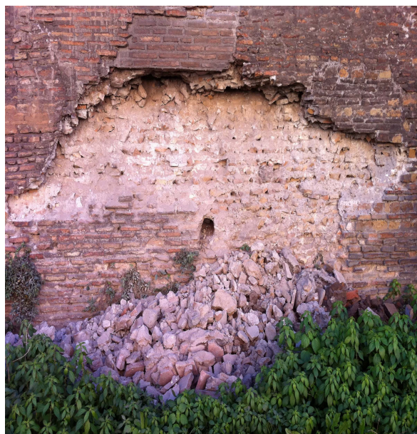
L'écroulement partiel (à gauche) des remparts auréliens dans le quartier Pinciano, (source Cervelli, mars 2012)
