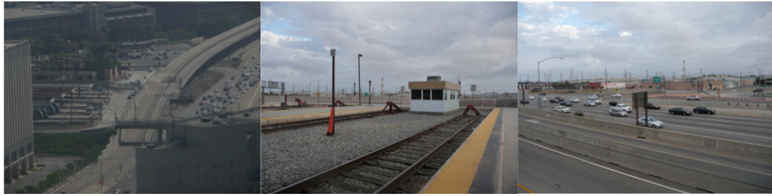
8. La grande vitesse à Union Station : des travaux d'ampleur (Ruggeri, 2013)
