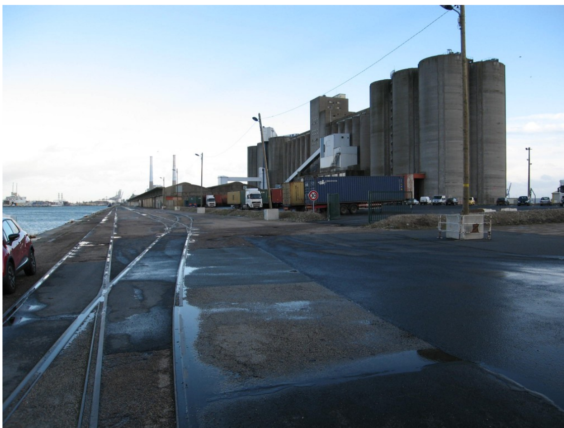
Illustration 5 : Silos à grains et à sucre du terminal céréalier, route du Môle central. Grues et aspirateurs ont été démontés (Pierre Thorez, 2014).
