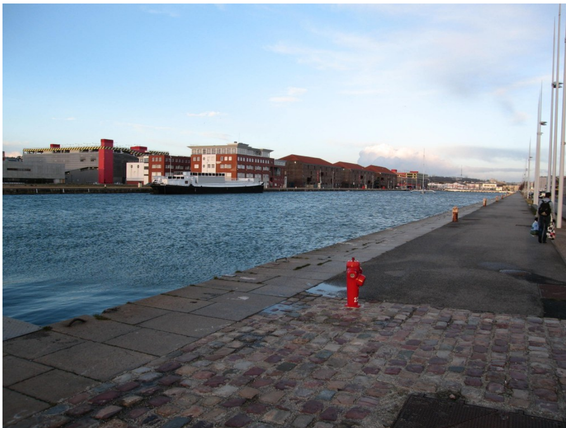
Illustration 8 : Bassin Vatine, avec l'IUT rénové et les docks transformés en centre commercial (Pierre Thorez, 2014).
