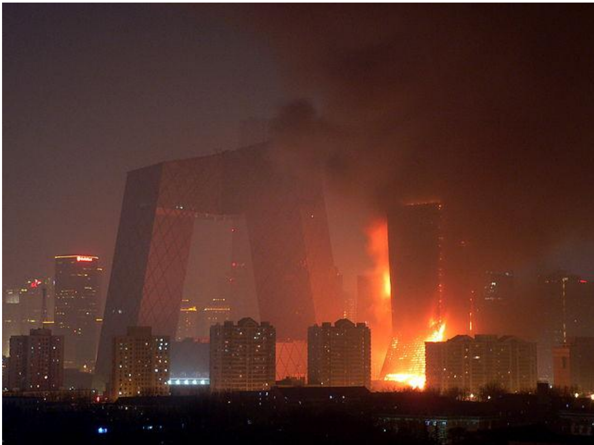
Incendie du CCTV Headquarters , projet de l'agence OMA dirigée par Rem Koolhaas.
