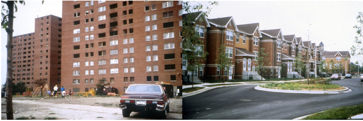
1. Le quartier Henry Horner de Chicago, avant (gauche) et après (droite) le programme HOPE VI ( Calthorpe Associates , 1994)
