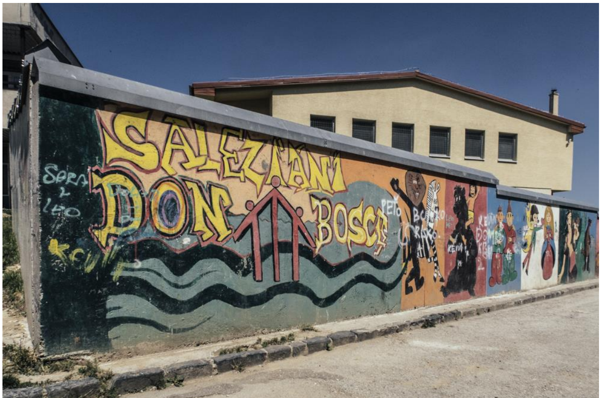
6. Le mur entourant le centre salésien est bien repeint et entretenu par rapport à l'état des murs du reste du quartier. Le mur et les grillages aux fenêtres du centre religieux marquent le contraste avec le quartier. (Alberto Campi | WeReport, 2015)
