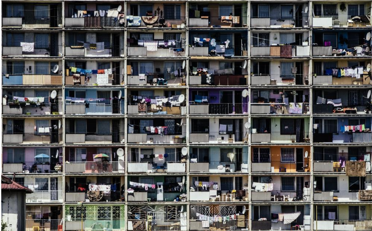
1. Façade du bâtiment en bon état du quartier de Lunik IX dans la ville de Košice. Ce bâtiment accueille les familles en condition de payer un loyer. (Alberto Campi | WeReport, 2015)
