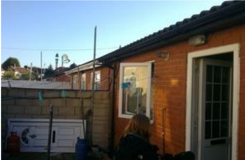
1. Exemple d'abris aux fonds de jardins contigus à l'arrière de maisons en bande dans une municipalité du Grand Londres (Site du Gouvernement britannique, 2012).
