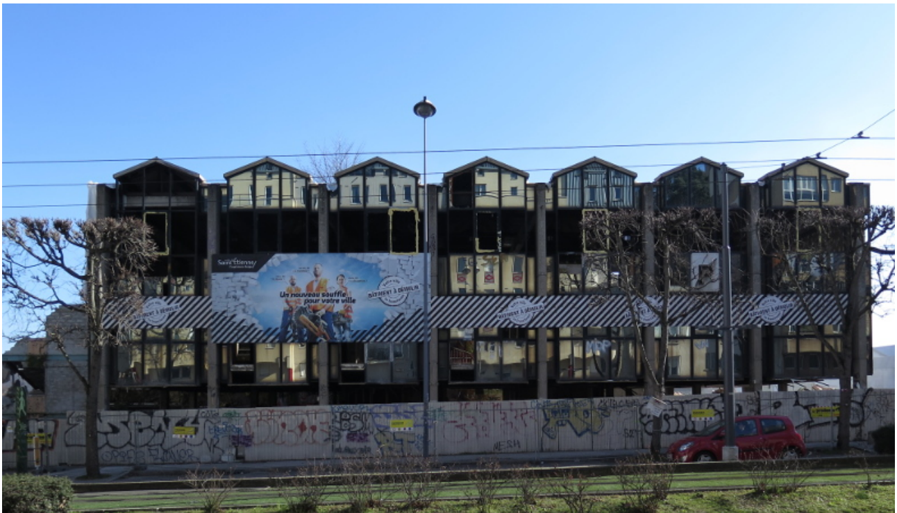
4. Chantier de démolition de la friche du Progrès, Saint-Étienne (Serra, 2017)
