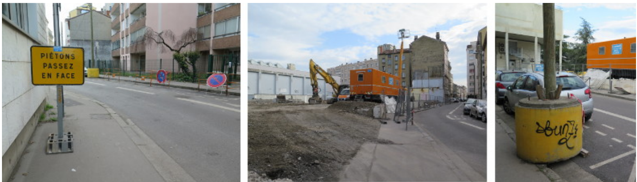
2. Autour d'un chantier de démolition, Villeurbanne (Serra, 2017)
