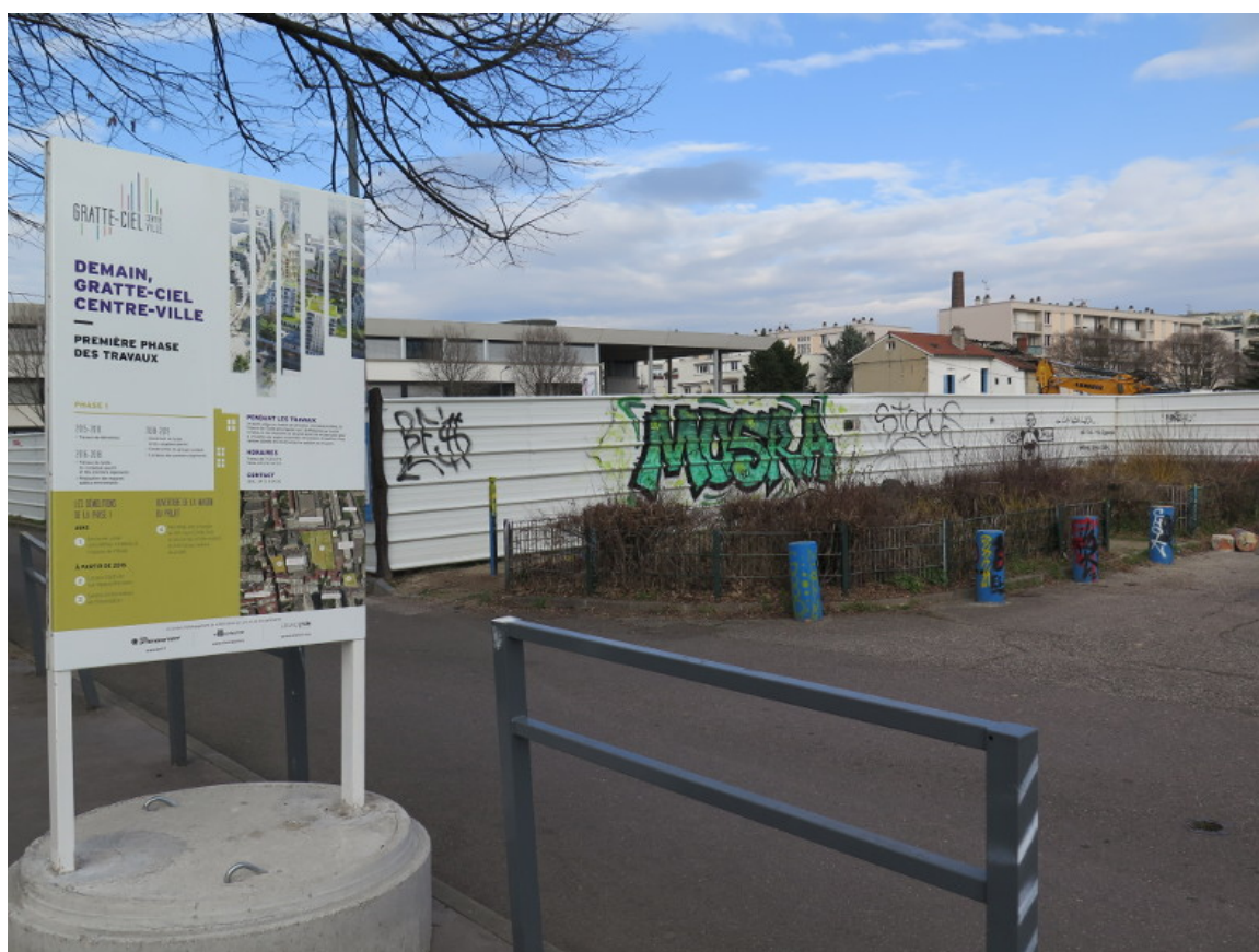
Couverture : Projet et chantier Gratte-ciel Nord, Villeurbanne (Serra, 2017)
