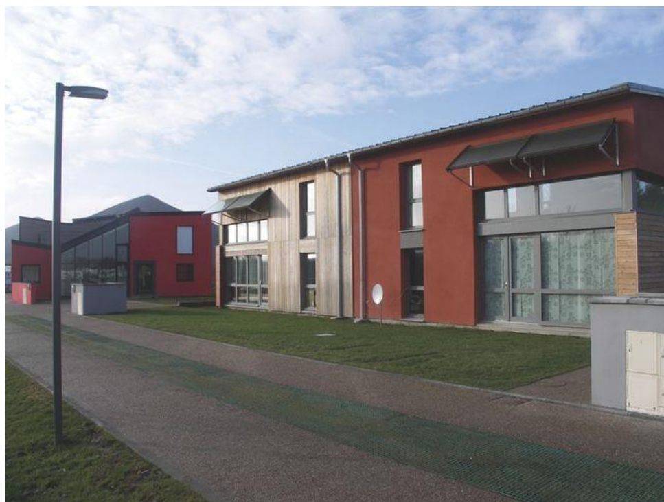
4. Villavenir : site d'expérimentation d'éco-construction (compte Flickr de la mairie de Loos)
