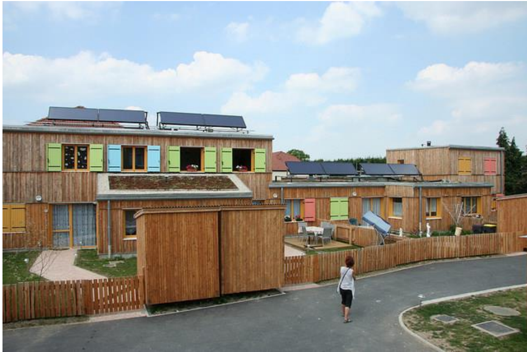
7. Exemple d'éconconstruction à Loos (compte Flickr de la mairie de Loos, 2016)
