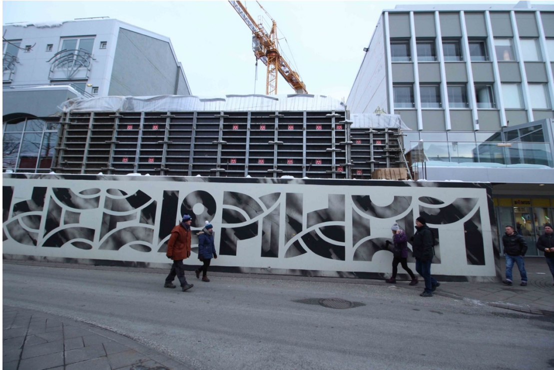
3. L'hôtel en construction (A.-C. Mermet, janvier 2019). Le rez-de-chaussée va être reconstruit à l'identique, mais le nouveau bâtiment comptera plus d'étages que sa version historique.
