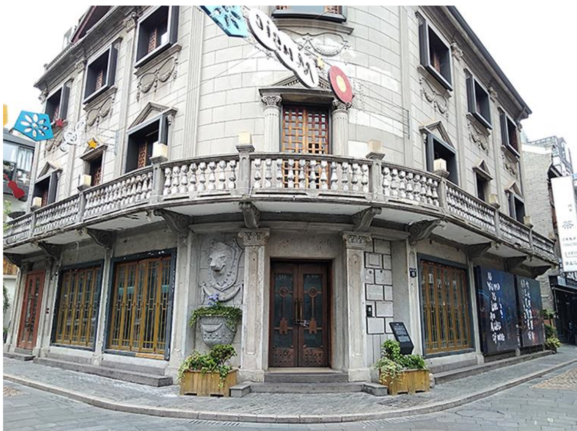
10. Résidence construite en 1935 et présentée comme « l'un des meilleurs exemples d'architecture occidentale en Chine » (extrait du panneau descriptif situé à l'entrée de la résidence). Quartier LaoWaitan (Ouellet, 2018).
