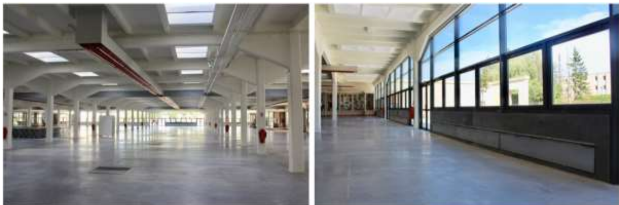
3. Rez-de-chaussée inondable (à gauche) et clapets (à droite) permettant l'évacuation et la circulation de l'eau en cas d'inondation, au rez-de-chaussée du bâtiment Hennebique (Lenouvel, 2017)
