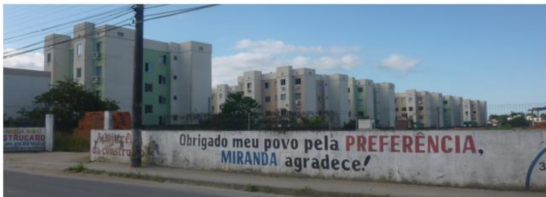
9. Les douze immeubles, disposés sur deux rangées autour de la route interne, de la résidence Jardins de Gaïa en construction, à Biguaçu. Une partie des huit bâtiments de Caminhos do Sol, à Palhoça. Les douze immeubles, de part et d'autre de la voie interne du Villagio Campo Bello, à Biguaçu. On remarque les similitudes entre ces ensembles (autrice, 2016).
