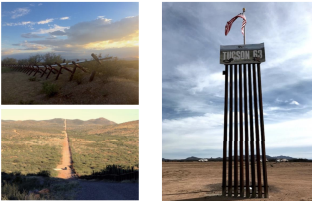
4. Remplacements des barrières garde-corps et contre les véhicules (photos de gauche) par des barrières hautes de neuf mètres (photo de droite qui est un exemplaire de démonstration) (C. Fortuné, 2020)
