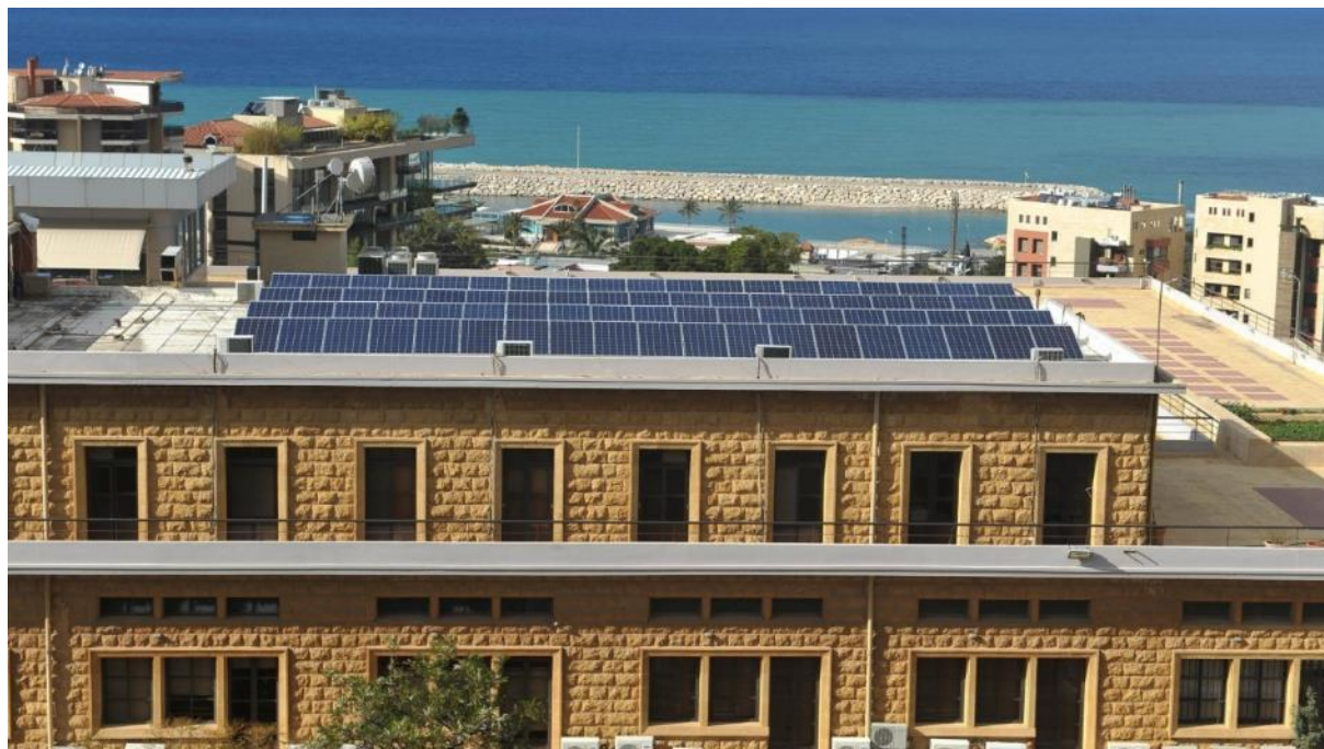
19. « Le PV c'est comme un 7 e générateur. » Lors d'un entretien, le responsable du projet de l'Université Saint-Esprit de Kaslik, Jounieh, Liban, explique que la production photovoltaïque est articulée avec une production diesel locale, et que l'installation des panneaux solaires a permis d'éviter l'achat d'un 7 e générateur (Alix Chaplain, 2021)
