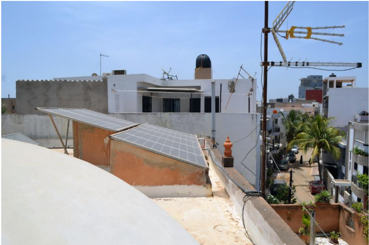
14. Installation PV sur toiture d'une villa bioclimatique à Dakar, Sénégal (Tomy Goulding, 2022)
