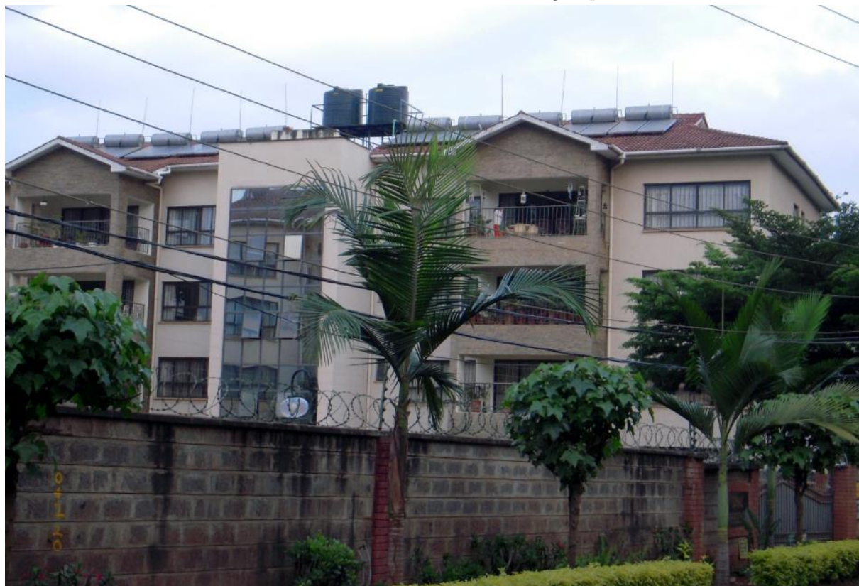
12. Dans le quartier aisé de Kileleshwa, Nairobi, Kenya, les chauffe-eaux solaires s'hybrident au réseau national pour réduire la facture d'électricité (Théo Baraillé, 2020)
