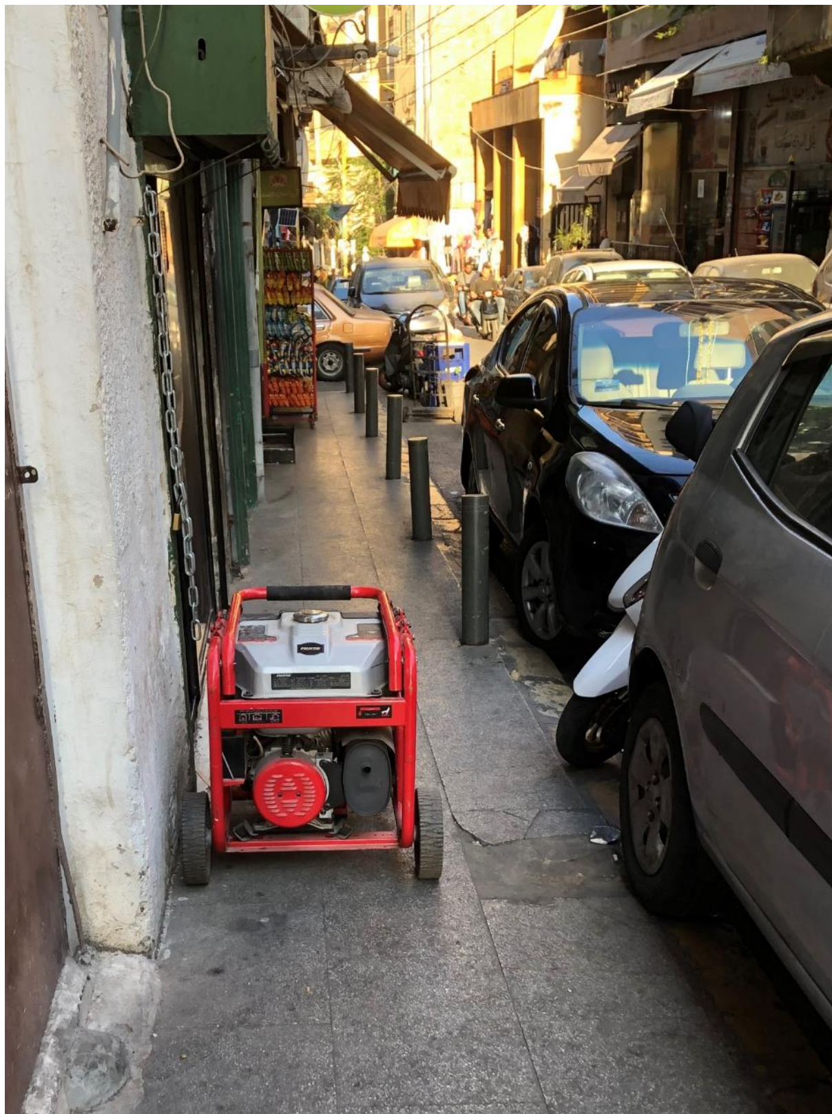
15. La prolifération des petits générateurs de secours invasifs dans les rues beyrouthines face à l'aggravation récente de la crise électrique, Beyrouth, Liban (Alix Chaplain, 2022)
