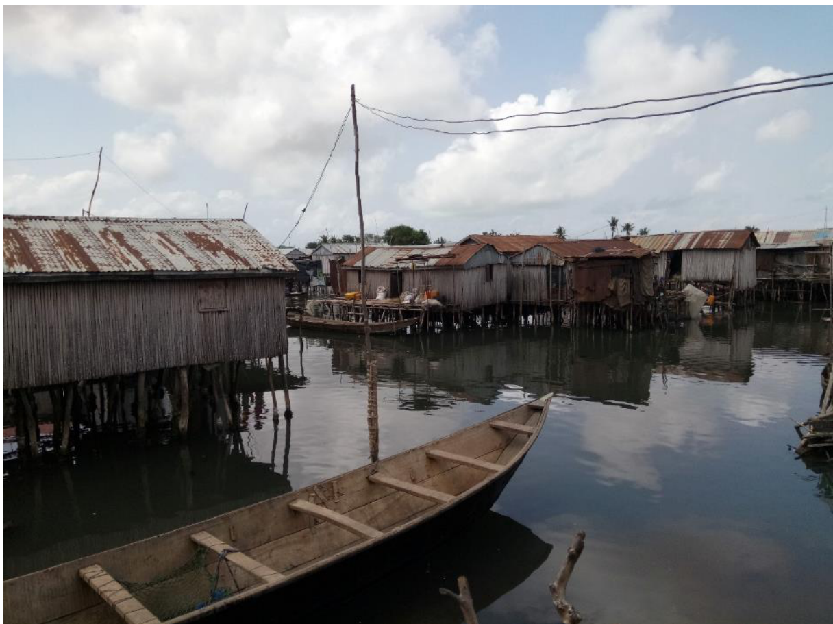
1. Des extensions bricolées qui électrifient jusqu'aux maisons sur pilotis de la lagune de Cotonou, Bénin (Mélanie Rateau, 2018)
