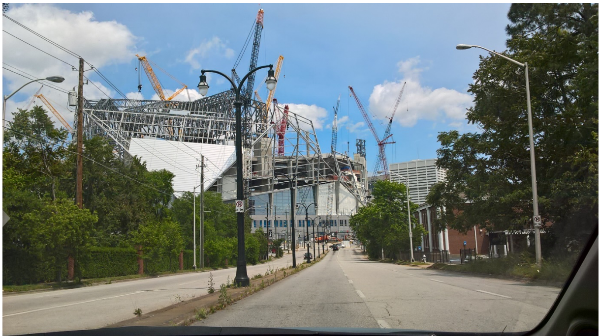
2. Le stade Mercedes-Benz en construction, Atlanta (Nafaa, 2017)
