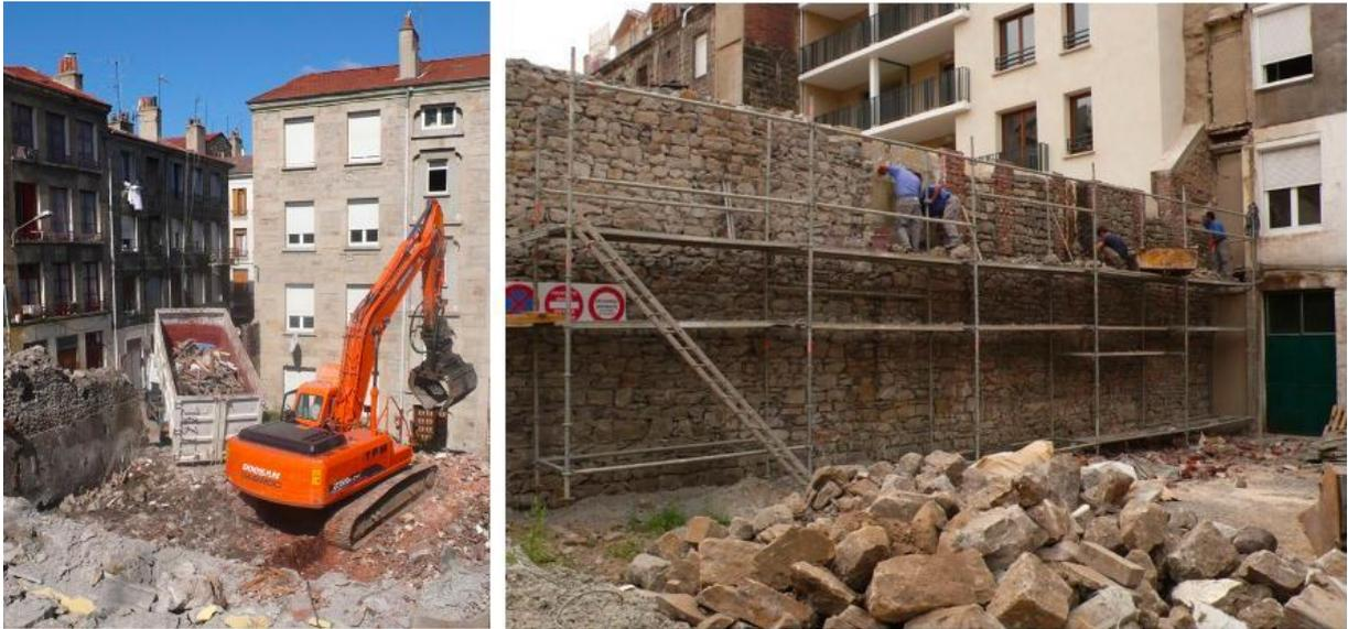
3. Le tri des déchets et le piquage des murs, qui consiste à retirer l'enduit existant pour mettre les pierres à nu. (É. Clavier, 2009)
