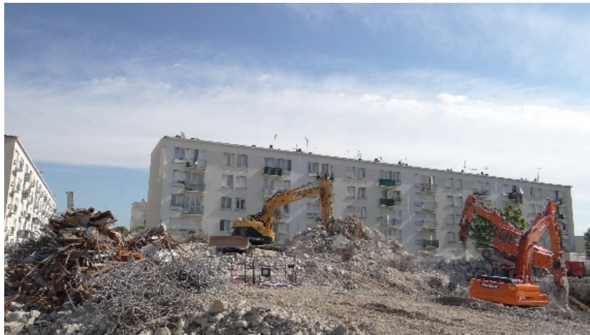
2. Tri et broyage sur site à des fins de réemploi, Bron (69) (Mongear, 2013)
