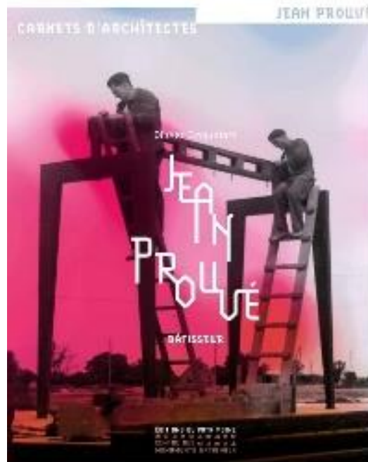
2. Le portique métallique, base du pavillon « Métropole » (Couverture du livre Cinqualbre O., 2016)
