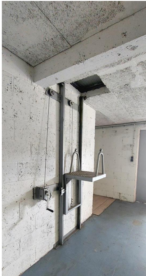
8. Vue intérieure du pavillon Prouvé : le monte-charge du sous-sol (Sonia Laloyaux, 14 mars 2025)
