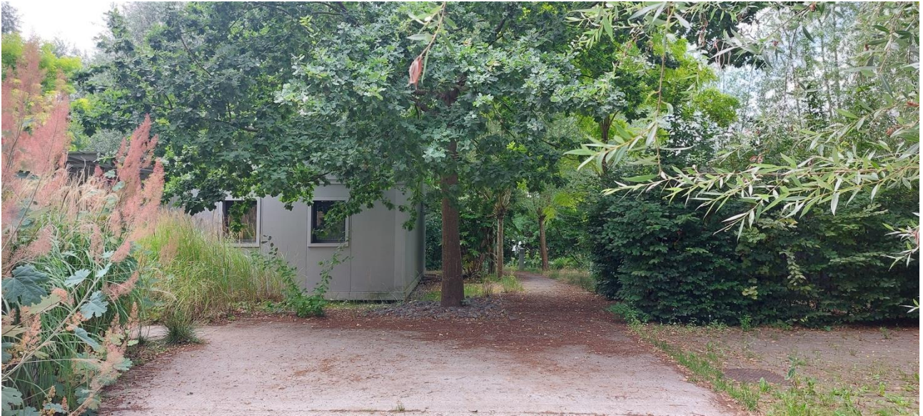
11. Vue du pavillon non surélevé : l'entreprise Holistic design s'y est installée (Sonia Laloyaux, 30 juillet 2025)
