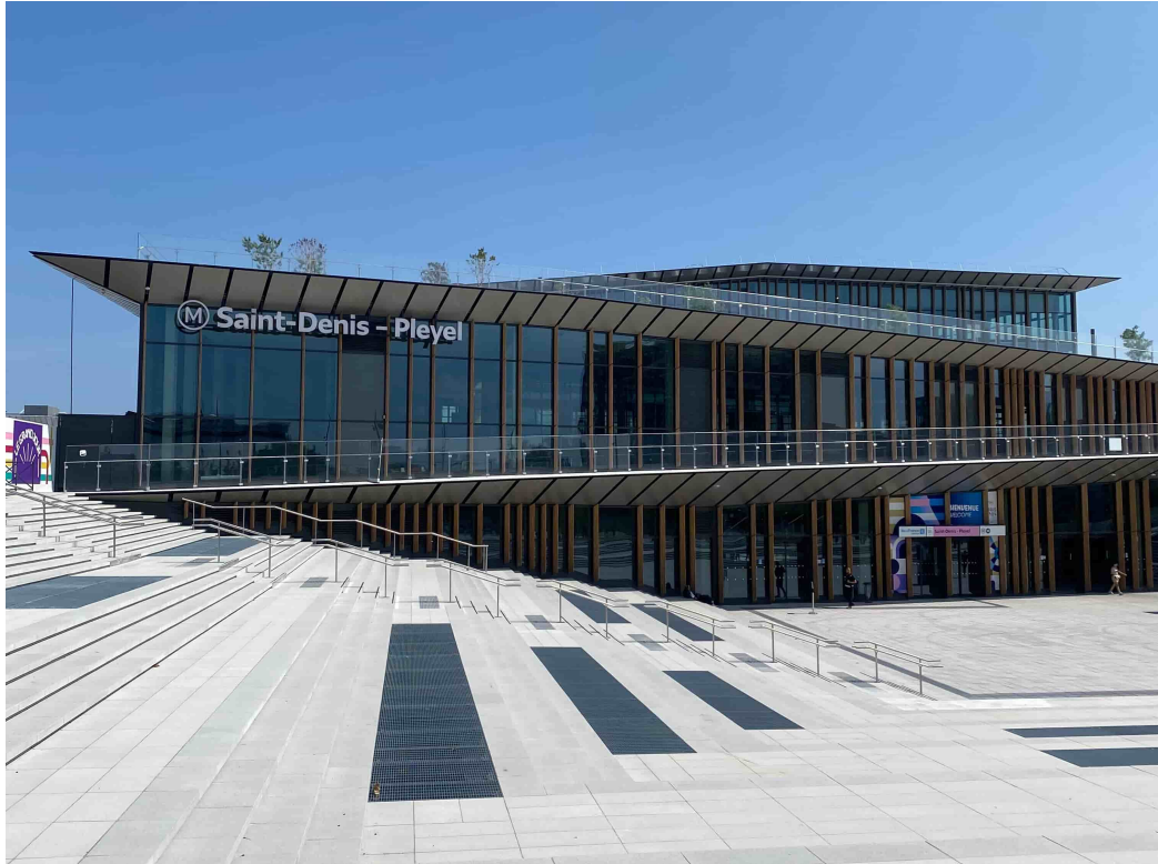
2- La gare de Saint-Denis Pleyel, futur hub du Grand Paris Express, à l'intersection des lignes 14,15, 16 et 17 (photographie de l'auteure, août 2025)
