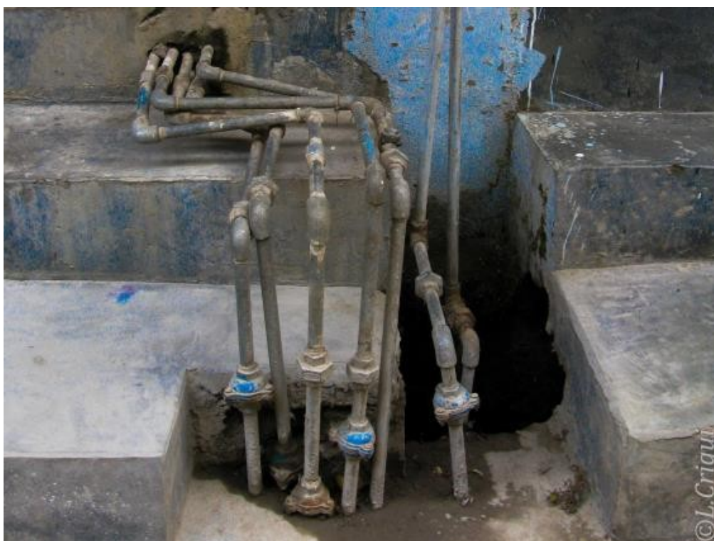
Photo 10. Connexions individuelles au réseau d'eau, embrouillées à la porte d'un immeuble (Delhi, 11 mars 2013)
