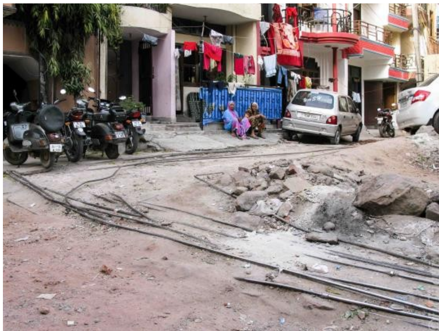
Photo 8. Réseaux de distribution d'eau « spaghettis » informels sans protection (Delhi, 10 mars 2013)
