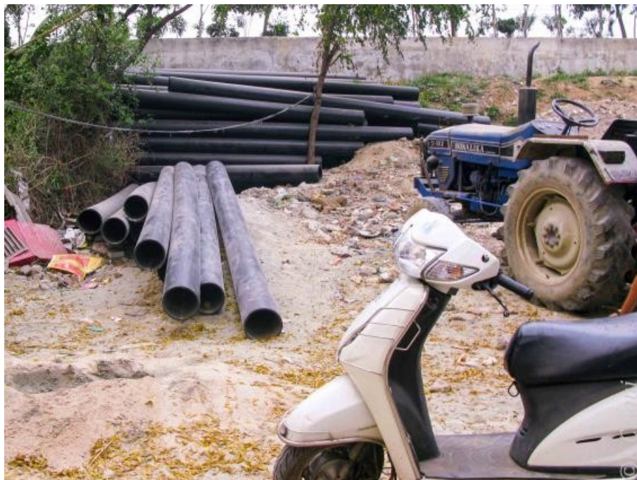
Photo 6. Dans l'attente du lancement de travaux d'assainissement, les tuyaux sont entreposés sur des terrains vagues disponibles dans le quartier, sans aucune protection contre les intempéries ou les vols. (Delhi, 11 mars 2013)
