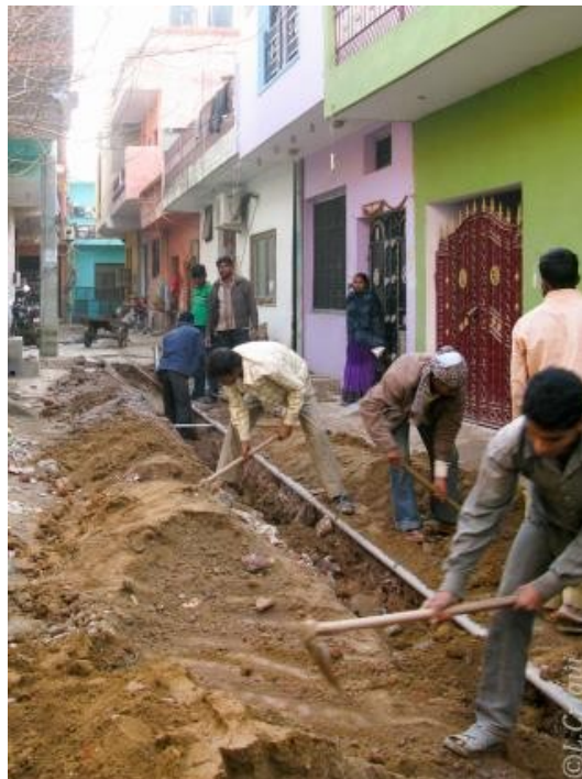
Photo 4. Dans des quartiers informels auto-construits par les habitants, les réseaux d'eau n'arrivent que dans un second temps ; les travaux dans ces ruelles étroites génèrent alors des perturbations importantes pour la circulation des habitants. (Delhi, 18 février 2013)
