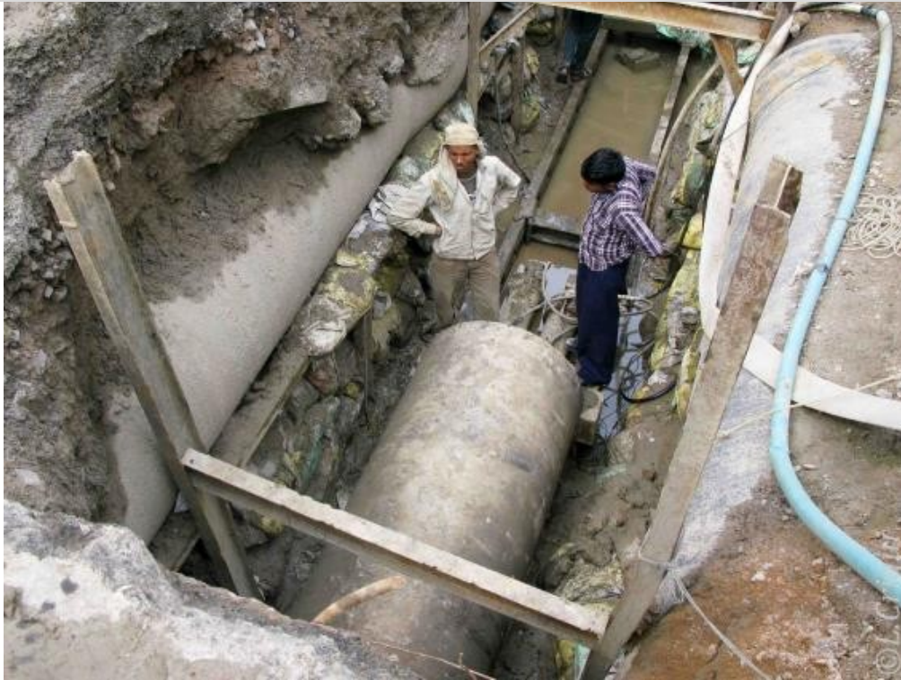
Photo 3. C'est en creusant que les ouvriers ont découvert les canalisations peu profondes de droite et de gauche ; ils n'en avaient pas été informés et ont dû installer plus profond les nouveaux tuyaux. (Delhi, 19 février 2013)
