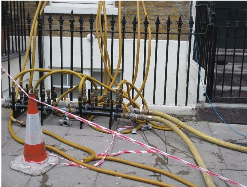
Couverture : Le désordre des tuyaux urbains. Instant londonien (Florentin, 2014)
