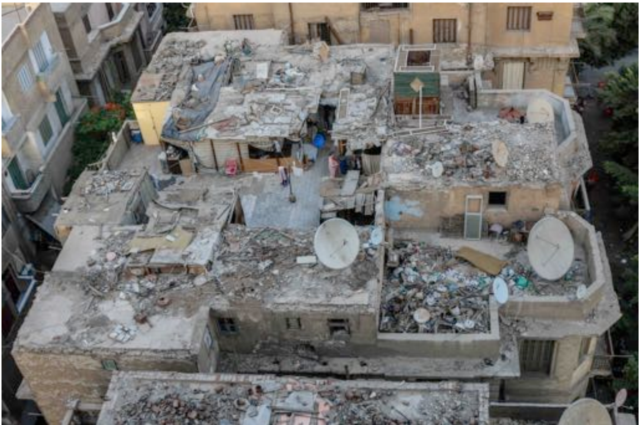
4. Vue plongeante sur le toit-terrasse d'un immeuble du quartier de Mounira. Plusieurs familles se partagent la terrasse et cohabitent autour de l'espace commun (Marie Piessat, juin 2017).
