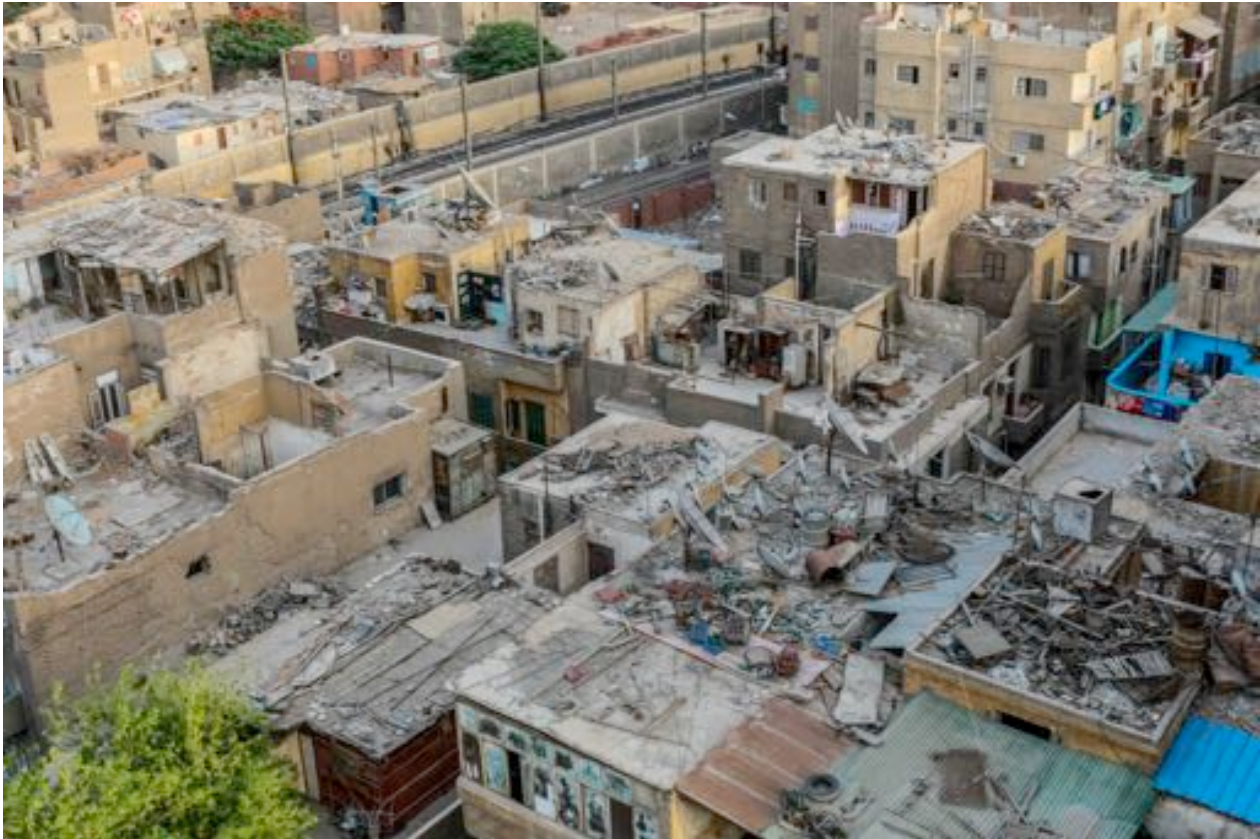
2. À Mounira, les habitants stockent ou entreposent des débris sur les toits pour ne pas avoir à payer pour leur évacuation. Ces actions participent involontairement à l'isolation du dernier étage (Marie Piessat, juin 2017).
