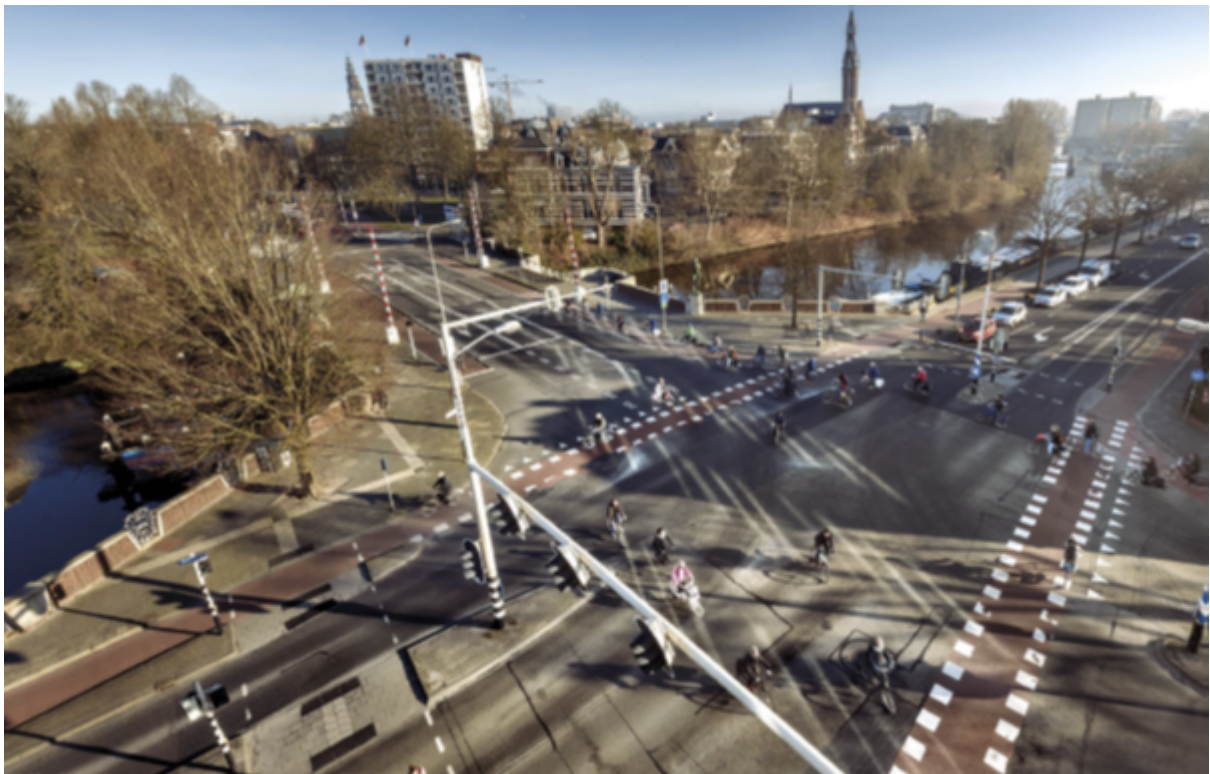
6. La technologie au bénéfice de la ville cyclable : priorité simultanée pour toutes les directions cyclistes avant le passage au vert pour le trafic motorisé à Groningue (de Rook, 2015).
